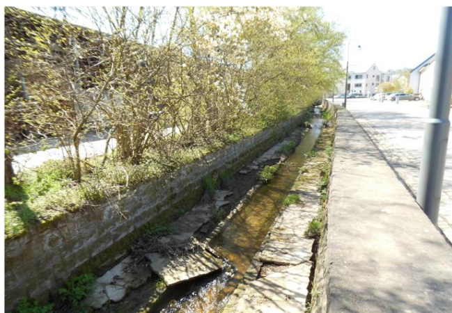
Foto gegen Fließrichtung
