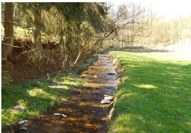
Foto gegen Fließrichtung
