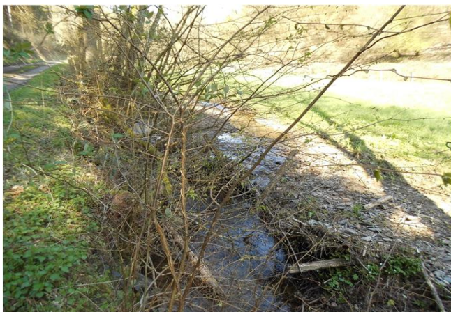
Foto gegen Fließrichtung
