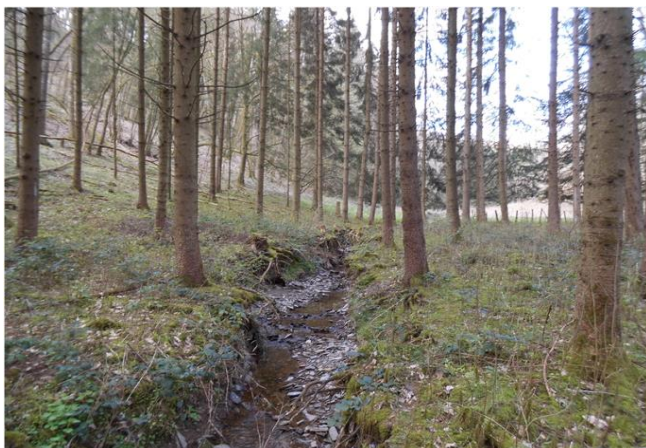
Foto gegen Fließrichtung
