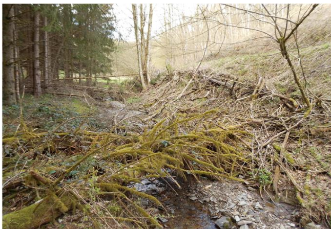
Foto gegen Fließrichtung
