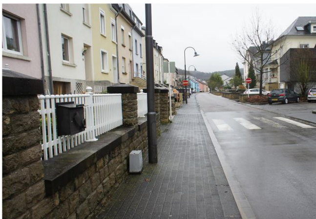
Foto gegen Fließrichtung
