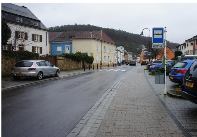
Foto gegen Fließrichtung
