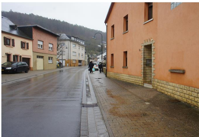
Foto gegen Fließrichtung
