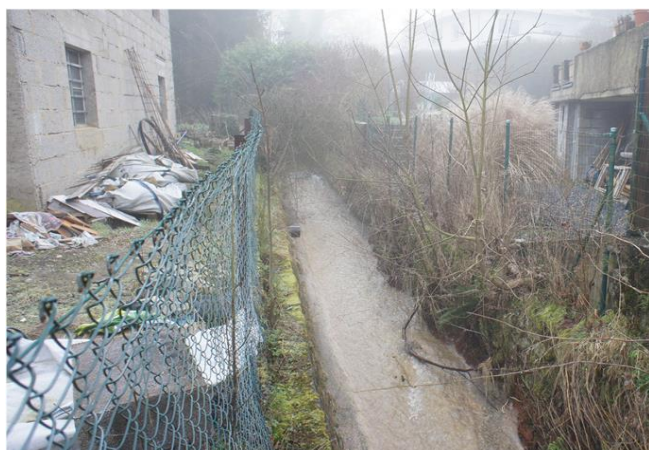
Foto gegen Fließrichtung
