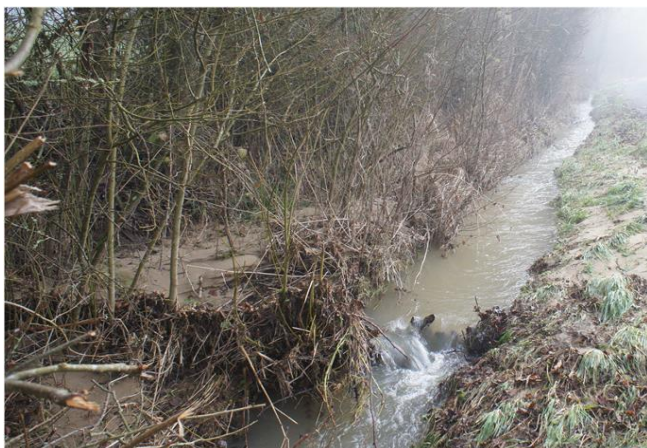
Foto gegen Fließrichtung
