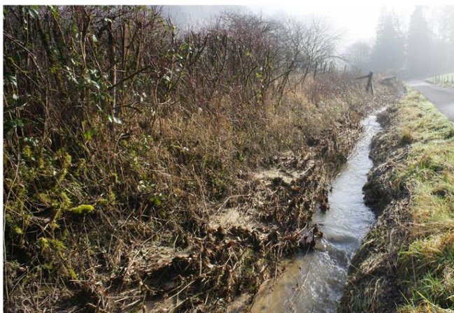
Foto gegen Fließrichtung
