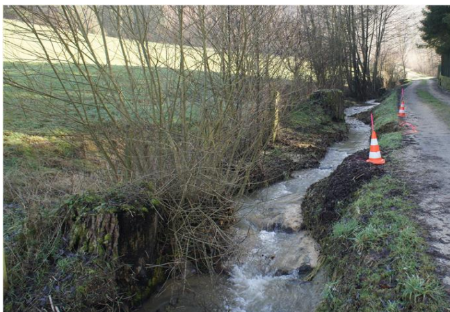
Foto gegen Fließrichtung
