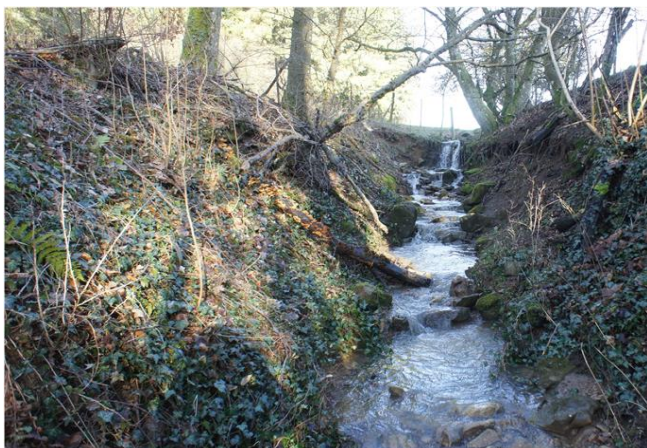
Foto gegen Fließrichtung
