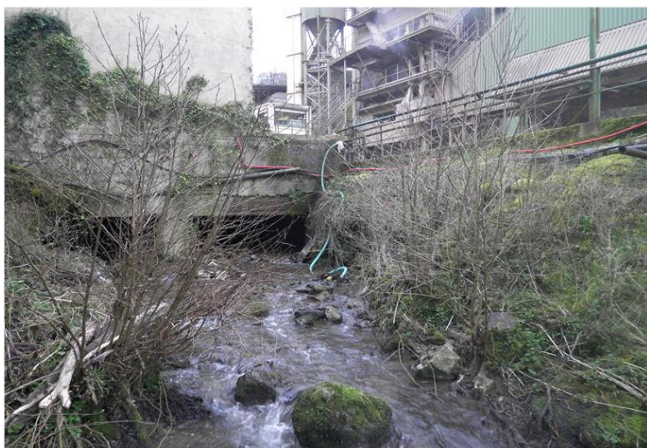
Foto gegen Fließrichtung
