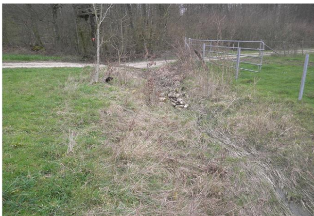
Foto gegen Fließrichtung
