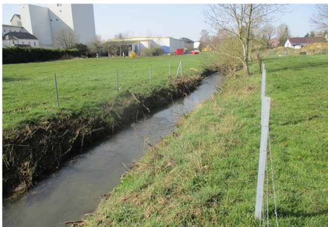
Foto gegen Fließrichtung
