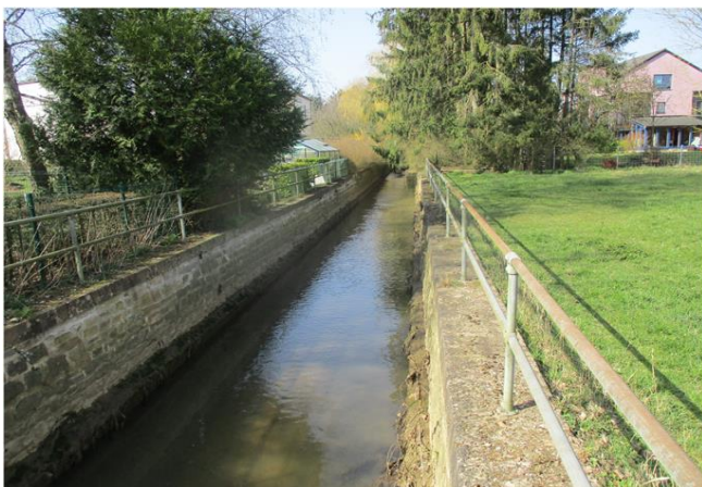
Foto gegen Fließrichtung
