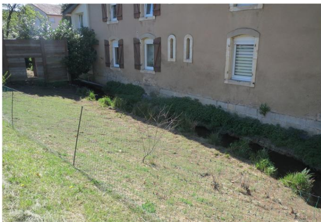
Foto gegen Fließrichtung
