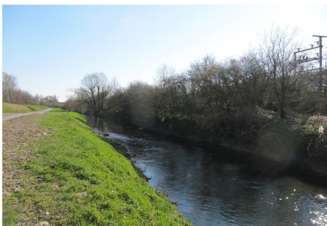
Foto gegen Fließrichtung
