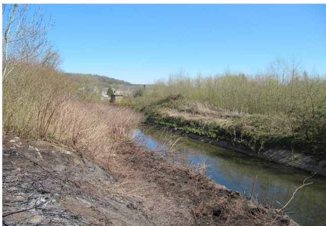
Foto gegen Fließrichtung
