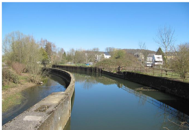
Foto gegen Fließrichtung
