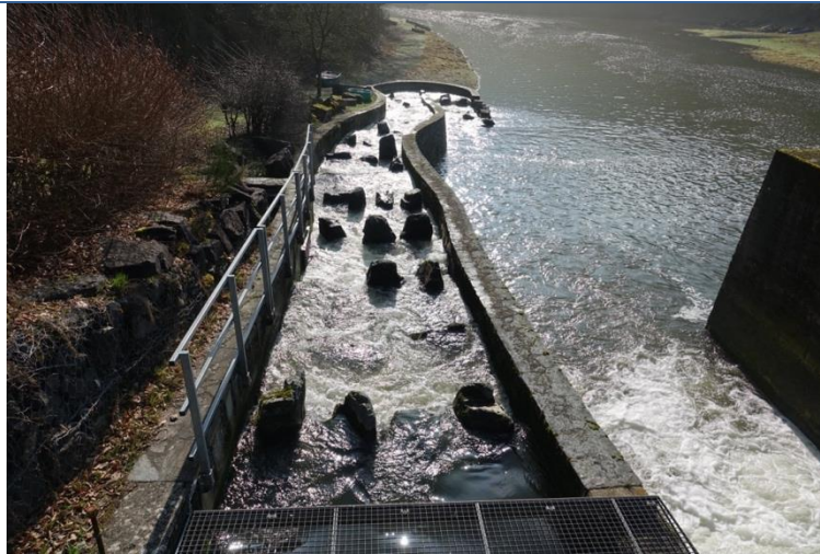
Abbildung 8-9: Fischpass bei Vorstaumauer Pont Misere (Begehung 23.3.2017)
