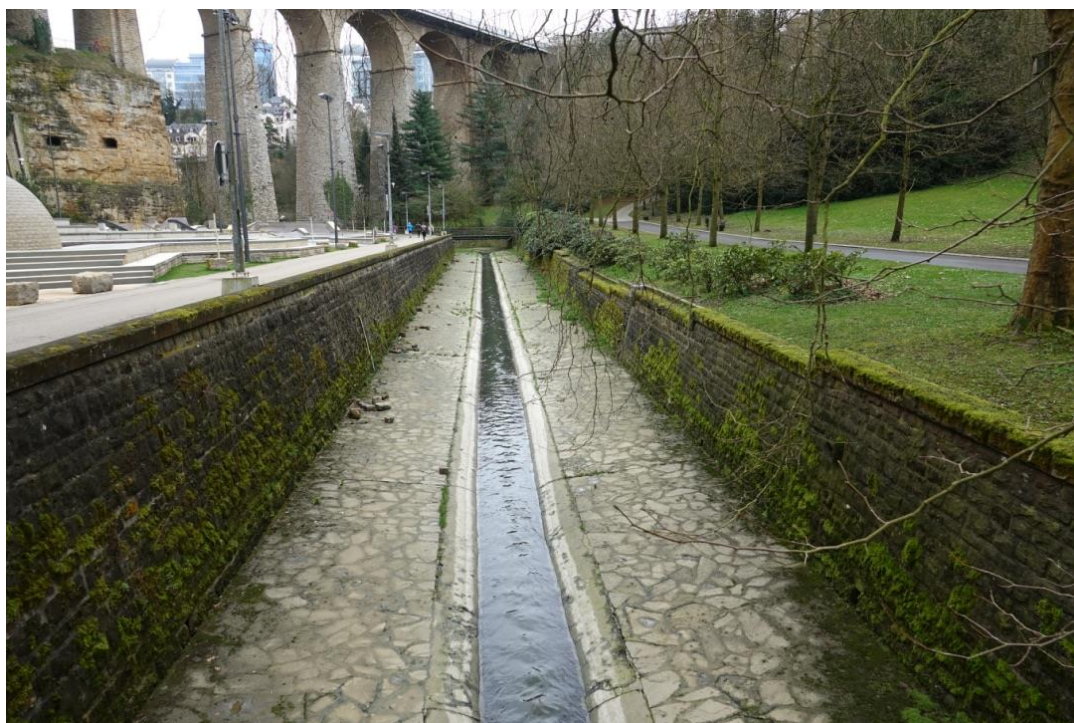
Abbildung 8-43: Derzeitige Situation der stark verbauten Petrusse (Begehung März 2017)
