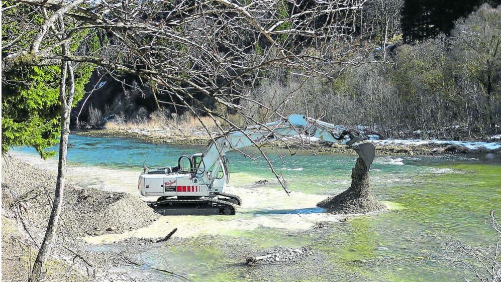
Abbildung 7-7: Schaffung von Laichplätzen für Fische durch Kieszugabe im Lech bei Kinsau ( www.merkur.de )
