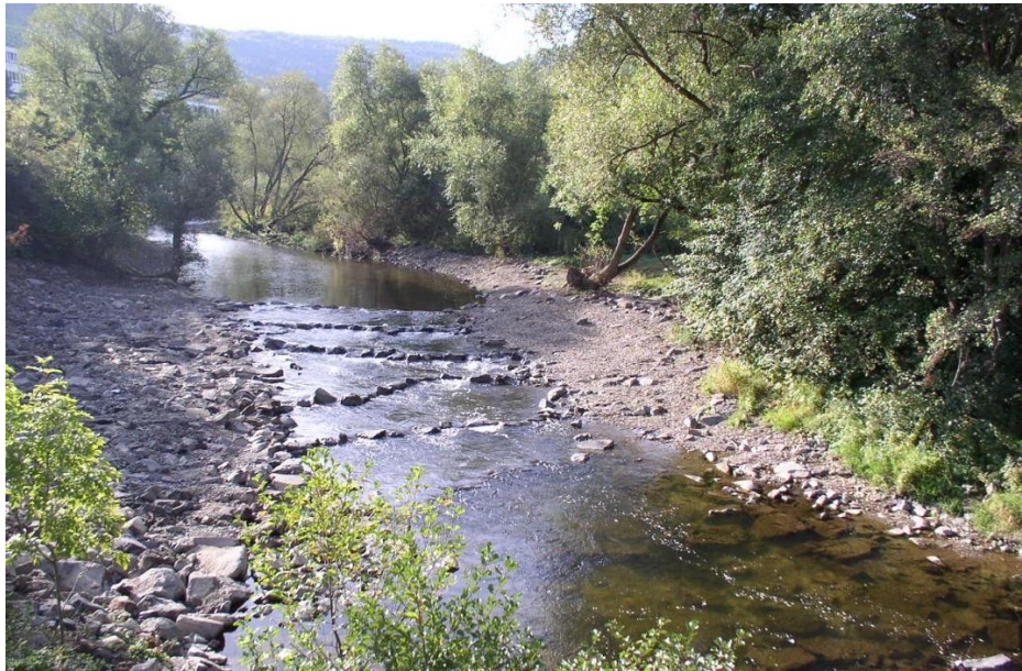
Abbildung 8-46: Beispiel einer fischpassierbaren Rampe (Gebler 2009)
