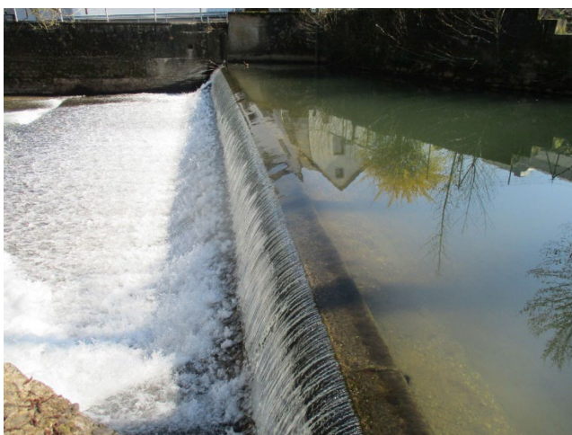
Abbildung 1-4: Zahlreiche Bauwerke beeinträchtigen die ökologische Durchgängigkeit der Fließgewässer, wie an der Attert bei Useldange.
