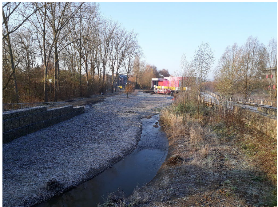
Verlauf der „Dipbech“ in Esch-sur-Alzette vor (oben) und nach (unten) dem Entfernen des Sohlverbaus | Nach dem Wegfall des Sohlverbaus können sich nach und nach naturnahe Strukturen ausbilden, die für variable Wassertiefen und Strömungsverhältnisse sorgen.
