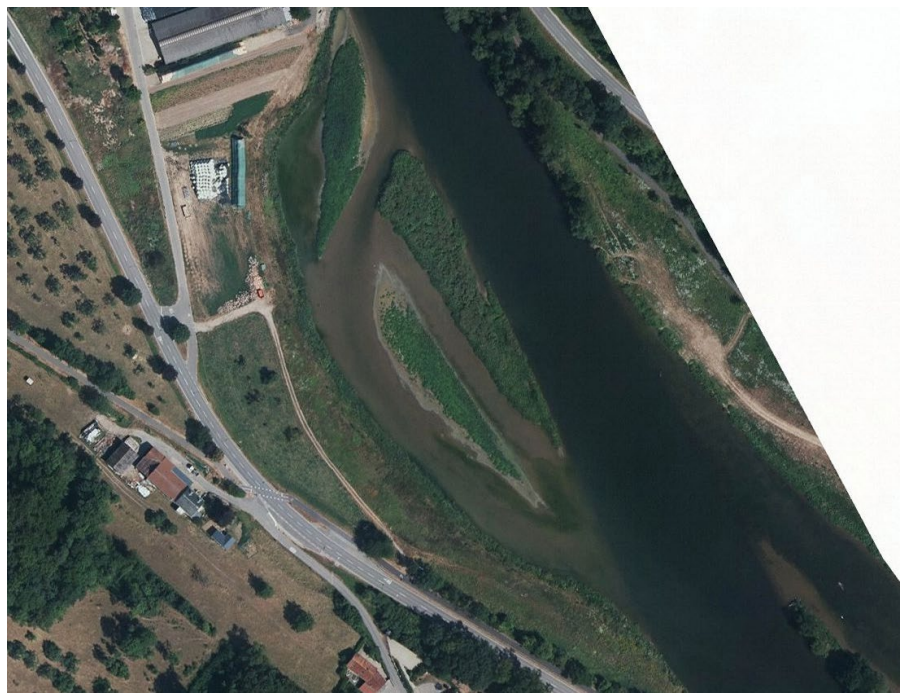
Anlage von Seitenarmen an der Sauer bei Steinheim vor (oben) und nach (unten) der Maßnahme | Durch die Reaktivierung oder Neuanlage von Nebengewässern entstehen vielfältige Ersatzhabitate, die im Hauptlauf nicht mehr vorhanden bzw. aufgrund bestimmter Restriktionen (z. B. Hochwasserschutz) nicht wiederherzustellen sind.
