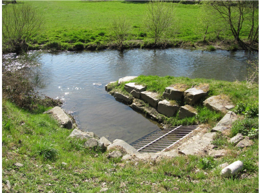
Einleitung in die Wiltz bei Bechel | Mögliche hydraulische Stoßbelastungen lassen sich durch eine lokale Profilaufweitung kompensieren.
