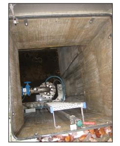
Der Brunnenschacht ist rd. 5 m tief und über eine Leiter begehbar. Der Schachtzugang liegt unmittelbar oberhalb der Bohrung.
