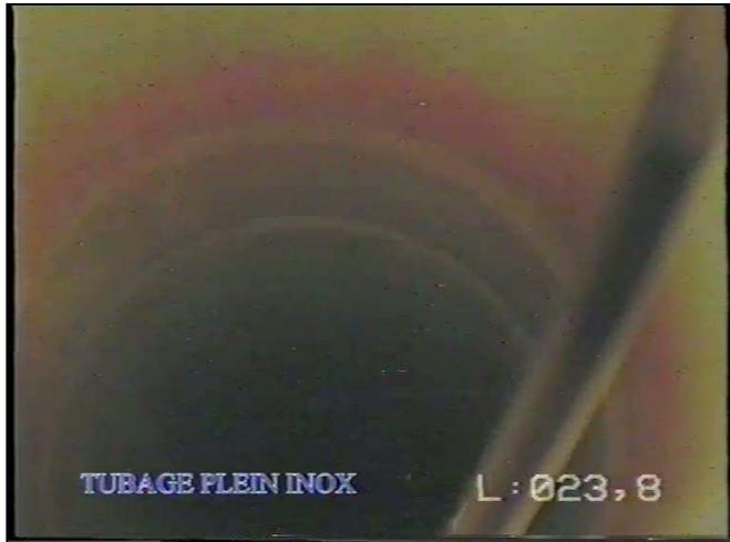
Exemplarische Aufnahmen der 2002 erfolgten TV-Kamerabefahrung. Das Aufsatzrohr zeigte sich in weiten Teilen frei von Belägen. Nur teilweise war eine leichte rötliche Färbung des Edelstahls zu erkennen. Oberhalb der ersten Filterstrecke wurden die Beläge des Aufsatzrohres etwas stärker, blieben insgesamt jedoch schwach.
