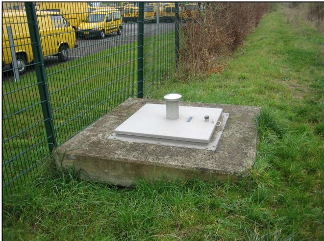
Die Messstelle schließt in einem Betonschacht ab, der an der Grenze zum Postgelände positioniert ist.
