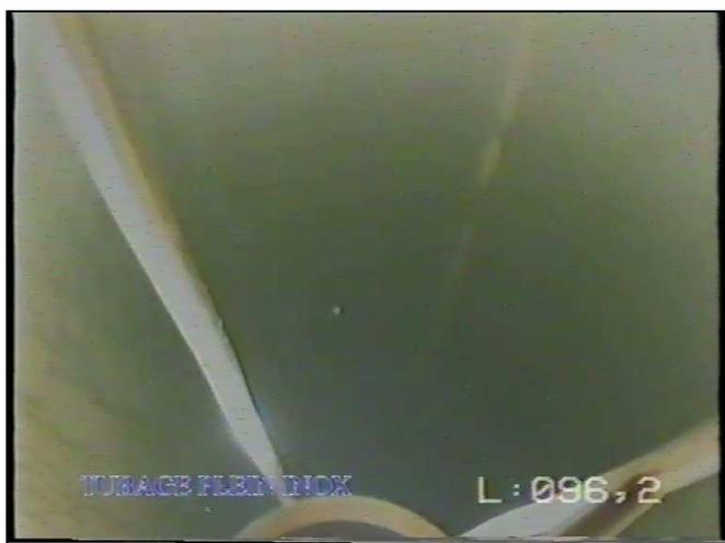
Zwischen ca. 94,6 m und 97,4 m unter ROK ist zwischen beiden Filterstrecken ein Vollrohr verbaut. Wie die Rohrbereiche ober- und unterhalb zeigte sich dies zum Befahrungszeitpunkt in sehr gutem Zustand. Beläge fehlten nahezu vollständig.
