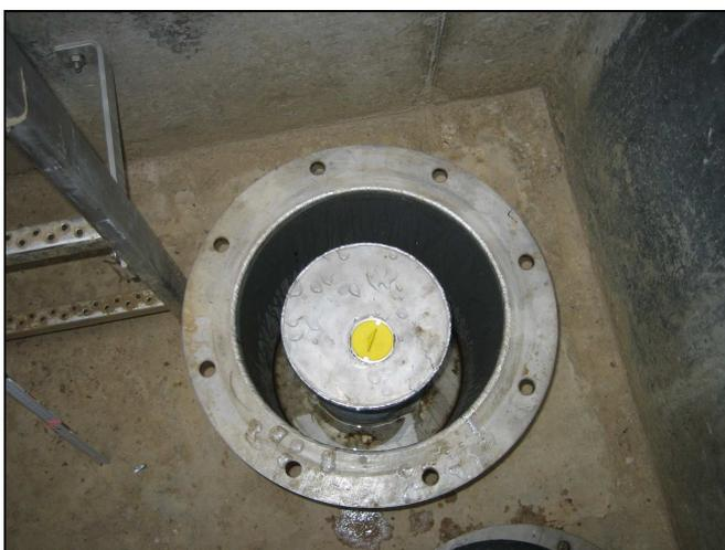
Die Messstelle verfügt über einen Edelstahlausbau. Der Flansch des Sperrrohrs schließt ca. 20 cm über dem Schachtboden ab.
