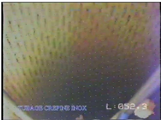
Bereits nach wenigen Dezimetern gingen die Verockerungserscheinungen deutlich zurück. Rohrrinnenwand und Filterschlitzte waren zu erkennen. Die Schlitzöffnungen erschienen gut durchströmbar. Beschädigungen der Rohrtour wurden nicht vorgefunden.
