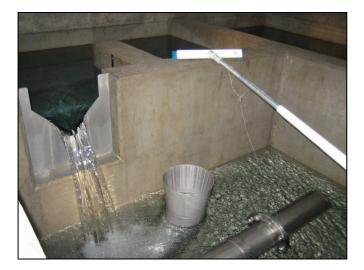
Im Behälter 1 erfolgt die Mischung der Wässer der Quellen TC1 und TC2, nachdem diese separate Sandfangbecken durchlaufen haben. Im Bild zu erkennen ist der Überfall der Quelle TC1 sowie die angehende Rohrleitung und der Überlauf.
