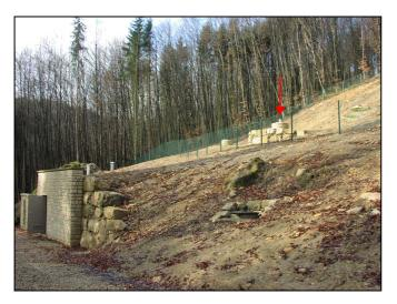
Das von den Quellen TC1 und TC2 gefasste Wasser wird durch einen Zwischenschacht (Pfeil) in die Sammelkammer 1 geführt. Analog hierzu wird das Wasser der Quellen TC3 und TC4 durch einen zweiten Zwischenschacht in die Sammelkammer 2 geführt.
