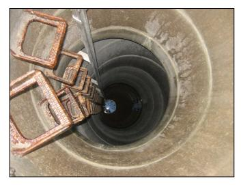
Die Sickerstränge verlaufen in ca. 8 m Tiefe. Der in Betonringen ausgeführte Quellschacht kann im Bedarfsfall über Tritteisen begangen werden.
