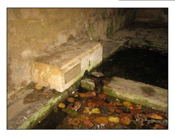
Eine Probenentnahme ist unmittelbar am Auslauf möglich. Eine repräsentative Schüttungsmessung kann hier nur dann erfolgen, wenn die gesamte Schüttung am Laufbrunnen zutage tritt. Hierzu ist der Schieber hinter dem Waschhaus entsprechend zu stellen.
