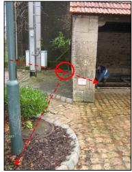
Das Wasser wird über eine Rohrleitung aus der Rue de Lavoir zugeführt, in der sich die eigentliche Fassung befindet. Die Leitung verläuft flach unter dem Straßenniveau. Im Schieberschacht (Kreis) erfolgt die Aufteilung der Schüttung.
