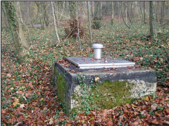
Die Quelle Leitschebiert 1 liegt im Waldgebiet südöstlich von Dudelange. Die Fassung schließt in ca. 80 cm über Flur mit einem Betonschacht ab. Die Anlage ist nicht umzäunt.
