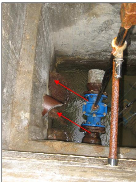
Der Fassung fließt Wasser über ein Steinzeugrohr (unterer Pfeil) sowie über eine rechteckige Öffnung in der Schachtwand zu (oberer Pfeil). Austretendes Wurzelwerk deutet auf Sickerwege hin, die auch in Verbindung mit den bakteriologischen Problemen zu sehen sind.
