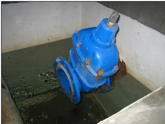
Das Quellwasser wird über ein Rohr aus westlicher Richtung zugeführt. Am Quellzulauf befindet sich ein Schieber.
