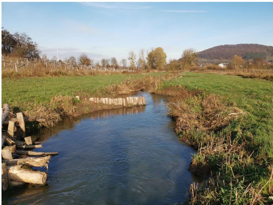
**Eigendynamische Entwicklung der Syre bei Mensdorf** | Strömungslenkern wie befestigte Baumstämme oder Pfahlbuhnen sorgen für Eigendynamik. Der Einbau von Strömungslenkern ist eine besonders kosteneffiziente Maßnahme, die allerdings eine gewisse Abflusssdynamik und Flächenverfügbarkeit voraussetzt.
