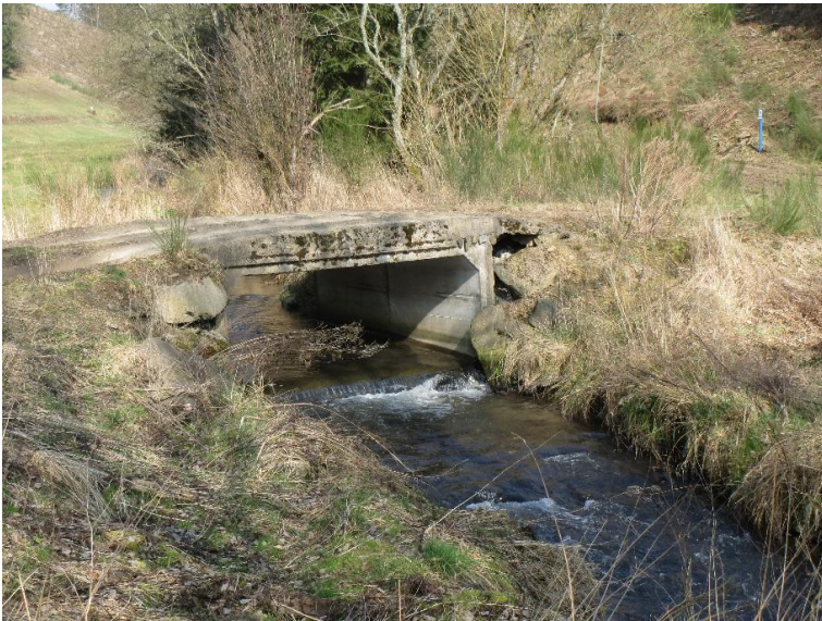
Durchlass; Ufer unterbrochen - Absturz; kleiner - Raue Gleite
