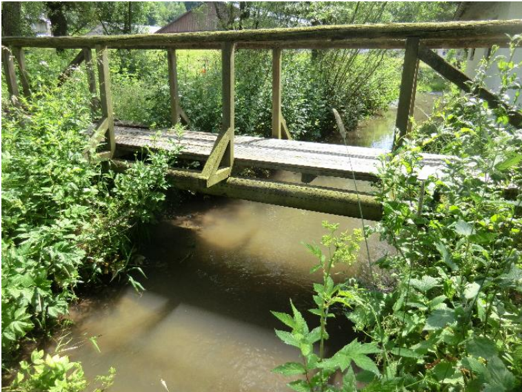
Durchlass; Ufer unterbrochen
