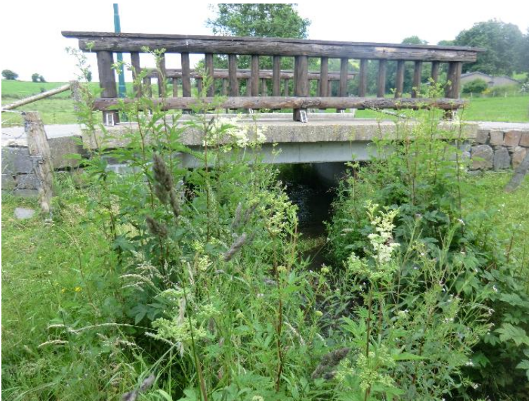
Durchlass; Ufer unterbrochen
