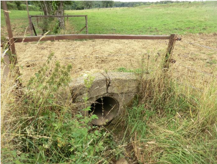
verrohrung mit kleinem absturz
