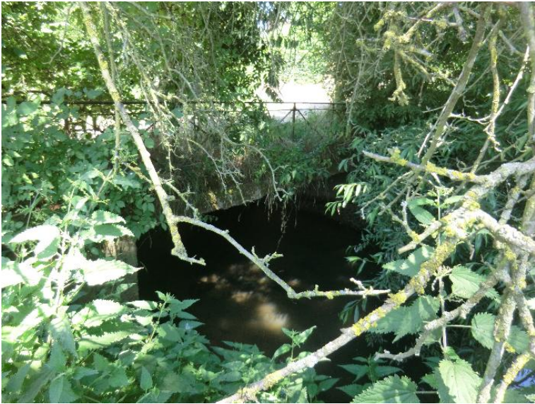
Durchlass; Ufer unterbrochen
