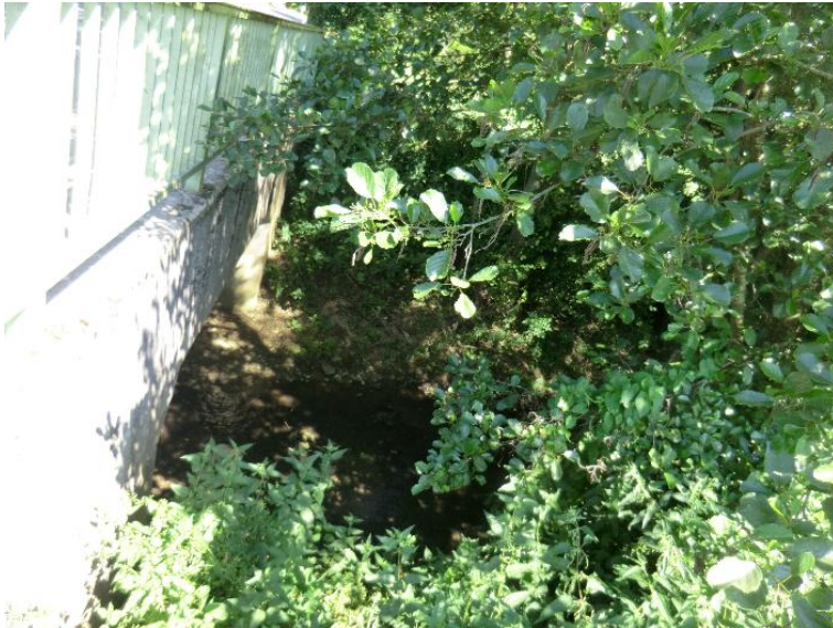
Durchlass; Ufer unterbrochen
