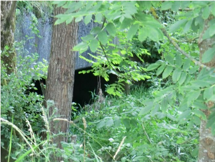
Durchlass; Ufer unterbrochen
