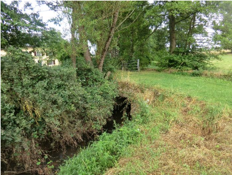
Durchlass; Ufer unterbrochen
