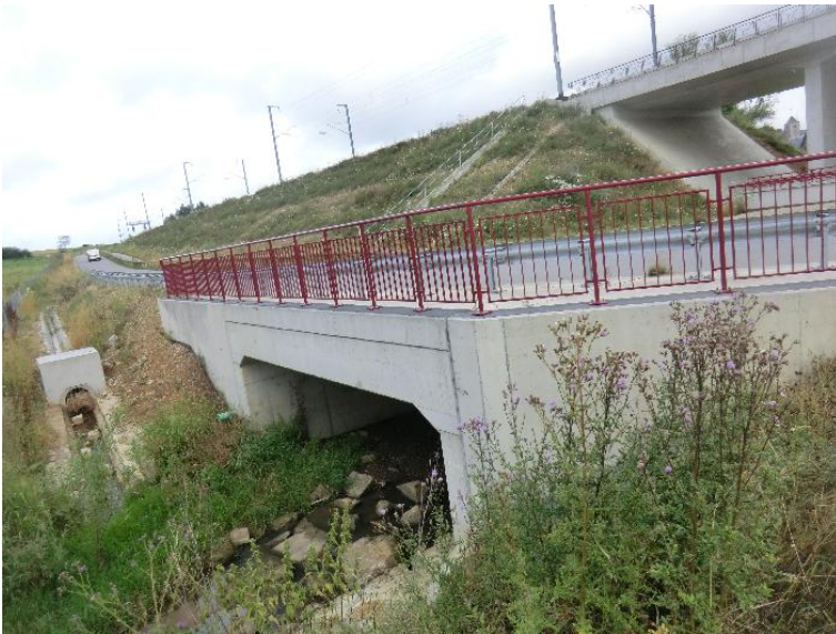
Durchlass; Ufer unterbrochen
