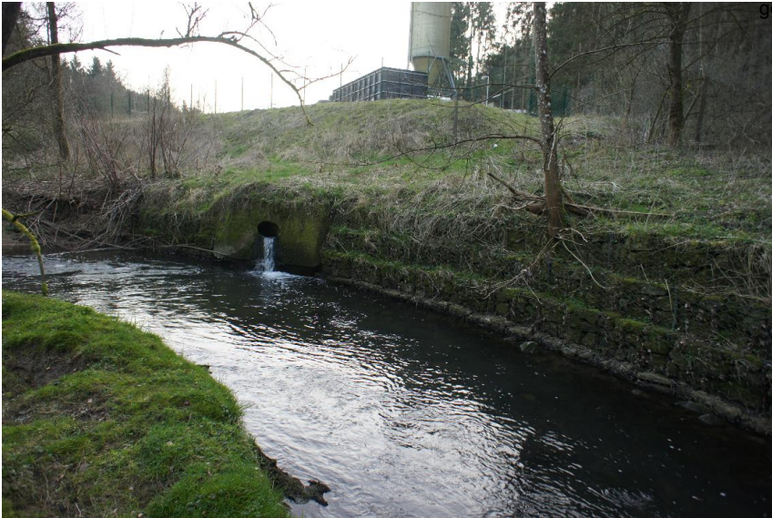
Einleitung - Uferverbau Steinsatz unverfugt - Zulauf Klaieranlage
