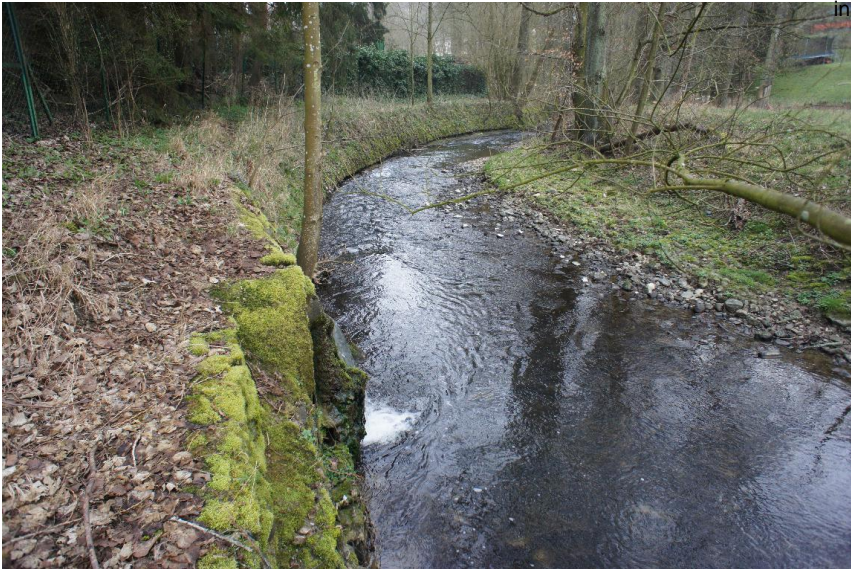
Einleitung - Uferverbau Steinsatz unverfugt
