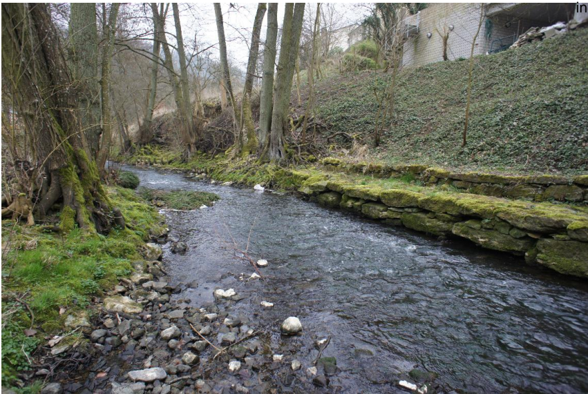
Uferverbau Steinsatz unverfugt - Gruenschnitt; Gruenabfall
