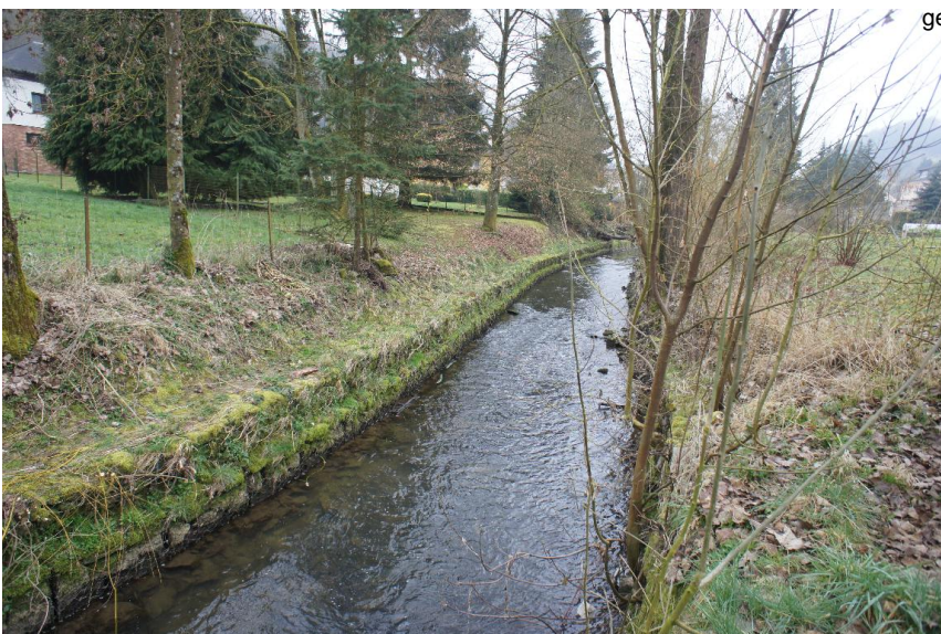
Uferverbau Steinsatz unverfugt
