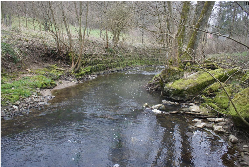
Uferverbau Steinsatz unverfugt
