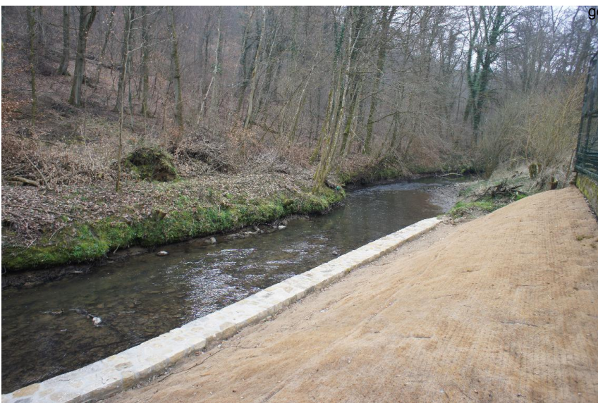
Lebendverbau - Uferverbau
