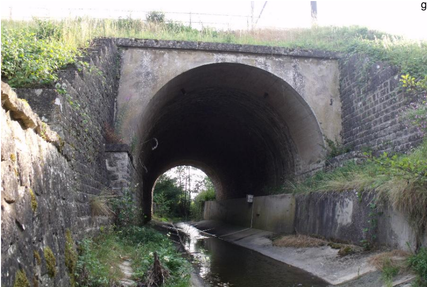
Durchlass; Ufer unterbrochen
