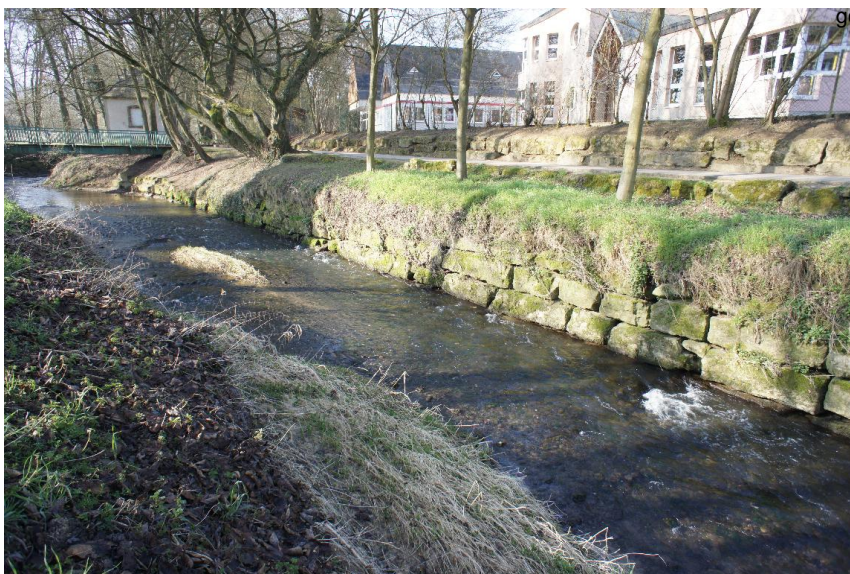
Ansatz Inselbank - Pflaster, Steinsatz unverfugt
