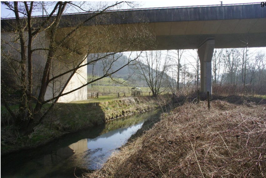
Durchlass; nicht strukturschaedlich - Uferverbau mit Steinbloecken
