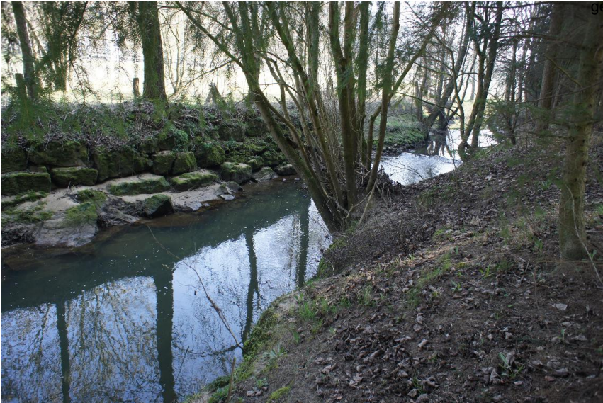
Nadelwald; Nadelforst - Uferbefestigung durch Steinblöcke
